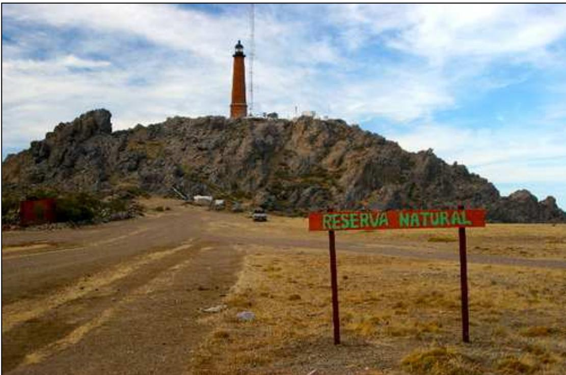
Está en plena Estepa patagónica sobre un morro de 70 metros de altura que debió ser dinamitado para levantar las instalaciones y el propio faro cuya estructura tiene 26 metros de altura.
