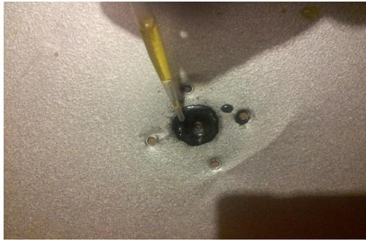
Figura 24: Aplicación de ácido muriático.
